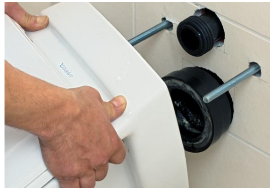
Nach aussen nicht in Erscheinung tretende Ausrüstungen mit baurechtlich untergeordneter Bedeutung, wie Lichtenanlagen, Bade-, Wasch und Abortanlagen, Wasser- und Elektrizitätsanschlüsse sowie Fallrohre, Schneefänger und untergeordnete Lüftungsaufsätze üblicher Konstruktion
